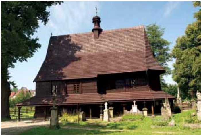
Kościół pw. św. Leonarda w Lipnicy Murowanej
